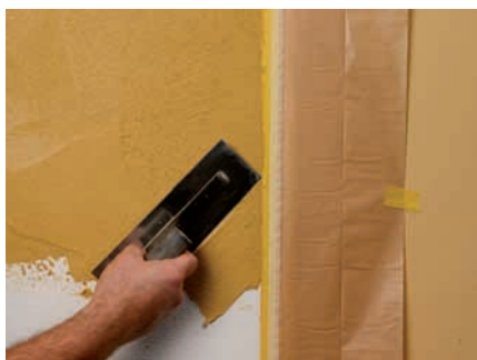
Aanbrengen tweede laag
