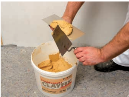
Opscheppen van de mortel
