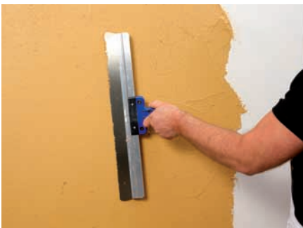
Gladtrekken met een spackmes
