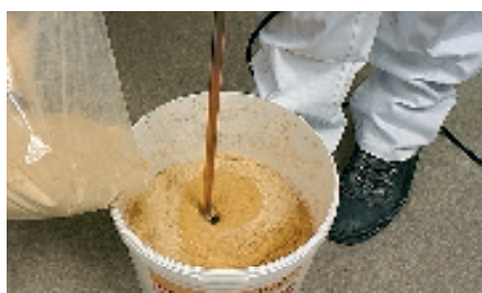
Emmerinhoud mengen met water. 30 min. laten rusten
