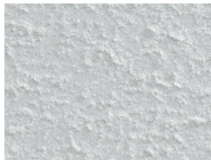
Oppervlak van een goed voorbereide gipskartonplaat.
