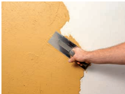
Opbrengen met de pleisterspaan
